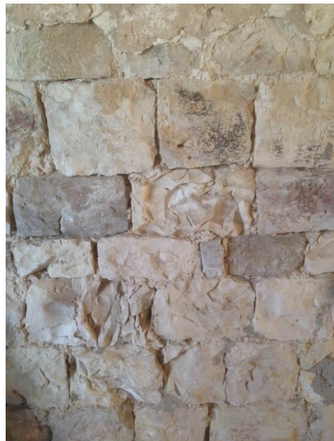
Sl. c.1.4.13 i 14_Detalji kamenog veza na zapadnom pročelju
