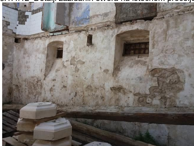
Sl. c.1.4.12 Detalji zazidanih otvora na istocnom pročelju
