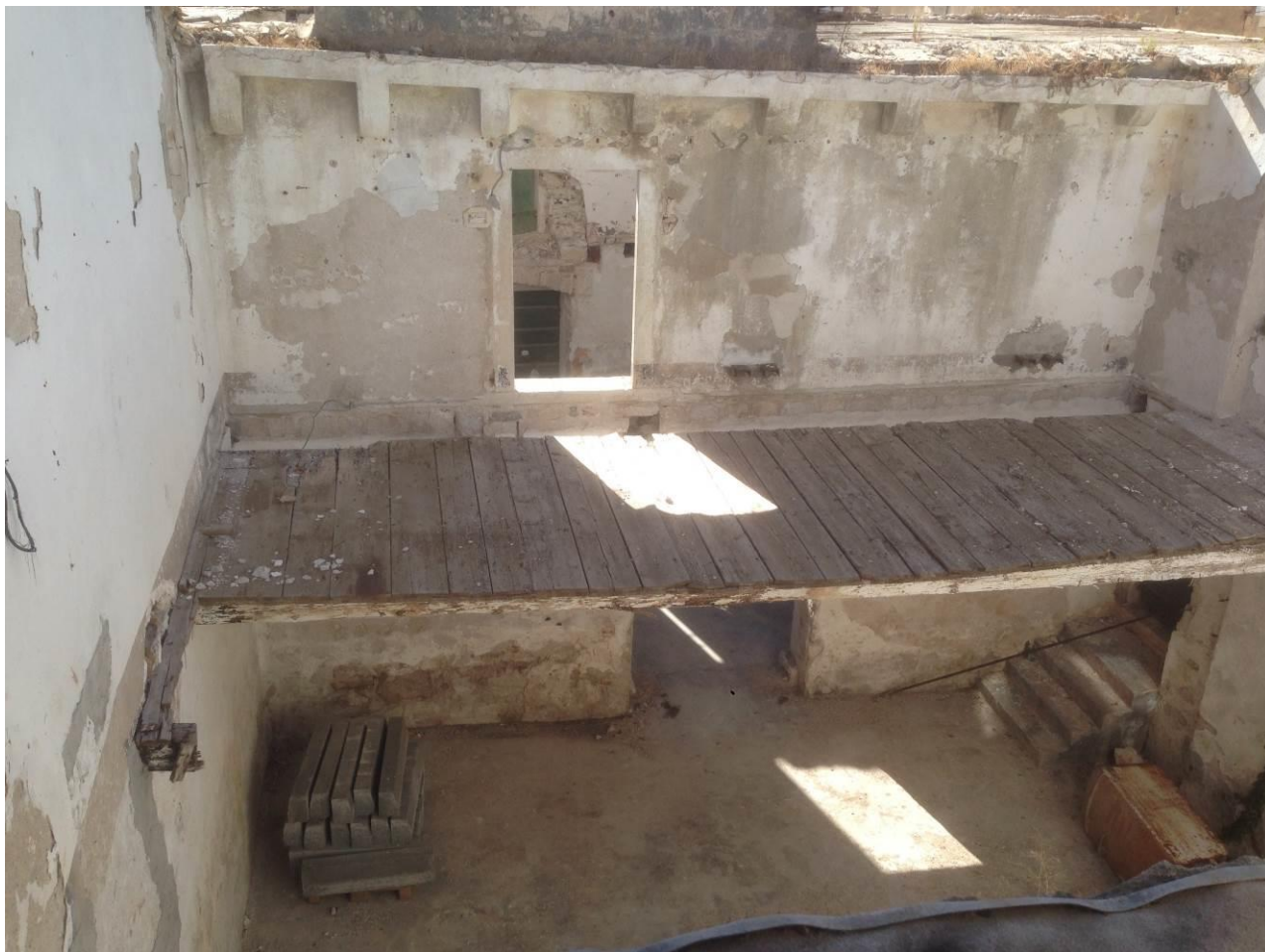
Sl. c.1.4.19_Detalj ostataka međukatne konstrukcije
