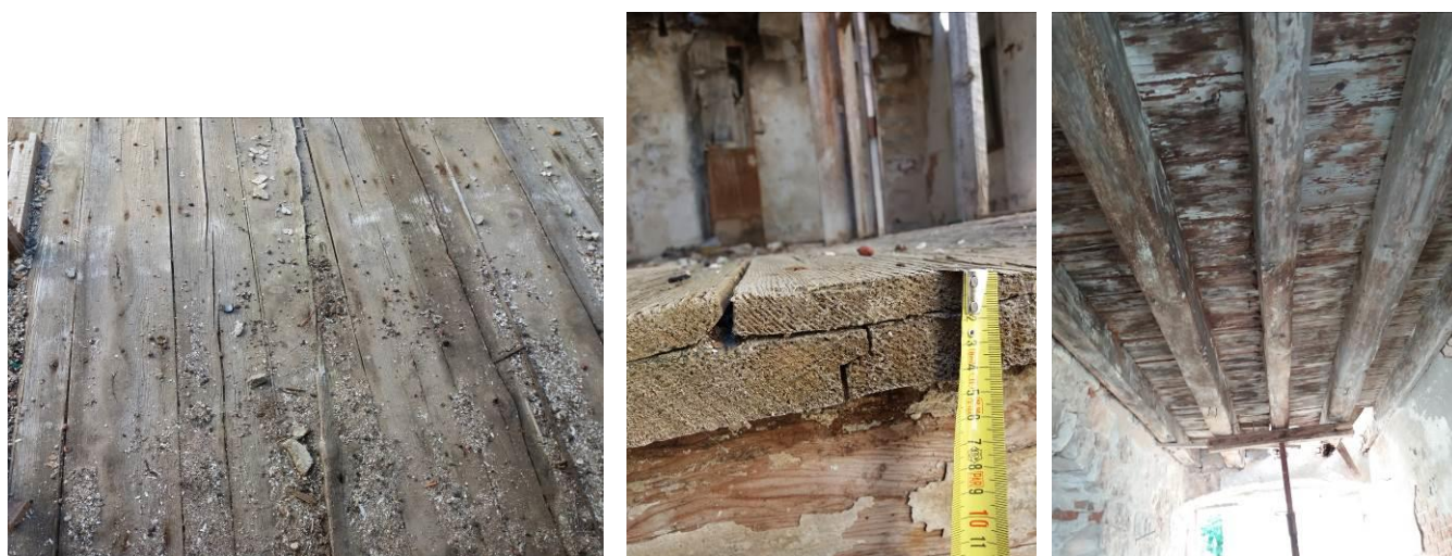
Sl. c.1.4.20, 21 i 22_Detalji međukatne konstrukcije i dasane podne obloge
